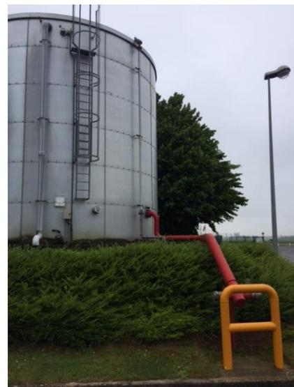
Les points d'eau artificiels (PEA) doivent être accessibles, signalés (fiches n° 1 et n° 2) et disposer d'une aire d'aspiration (fiche n° 3). Ils respectent les caractéristiques techniques liées à la mise en aspiration (fiche n° 4).
